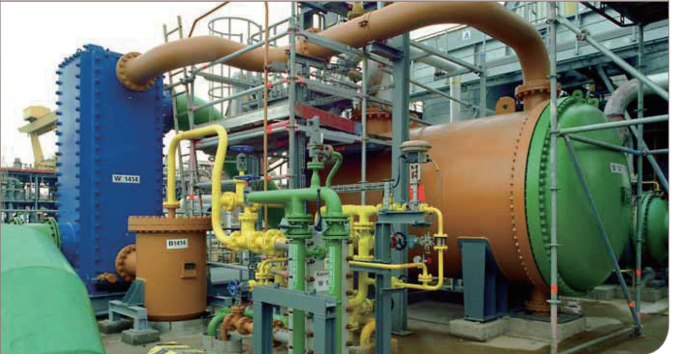
Fully welded heat exchanger (Compabloc)와 S&T 열교환기가 연속으로 설치되어 있습니다. Fully welded heat exchanger (Compabloc)는 열 부하가 높고 condensing 및 sub-cooling이 가능하면서도 크기는 훨씬 작습니다.
